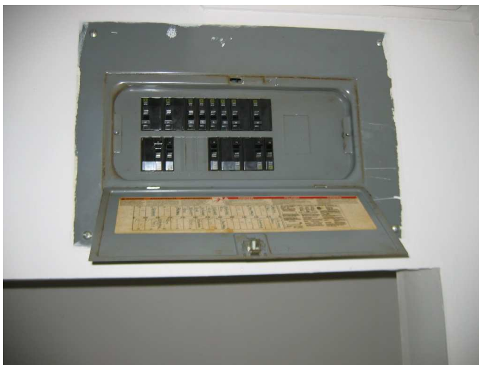
Photo 6 : Panneau électrique dans un appartement à disjoncteur
