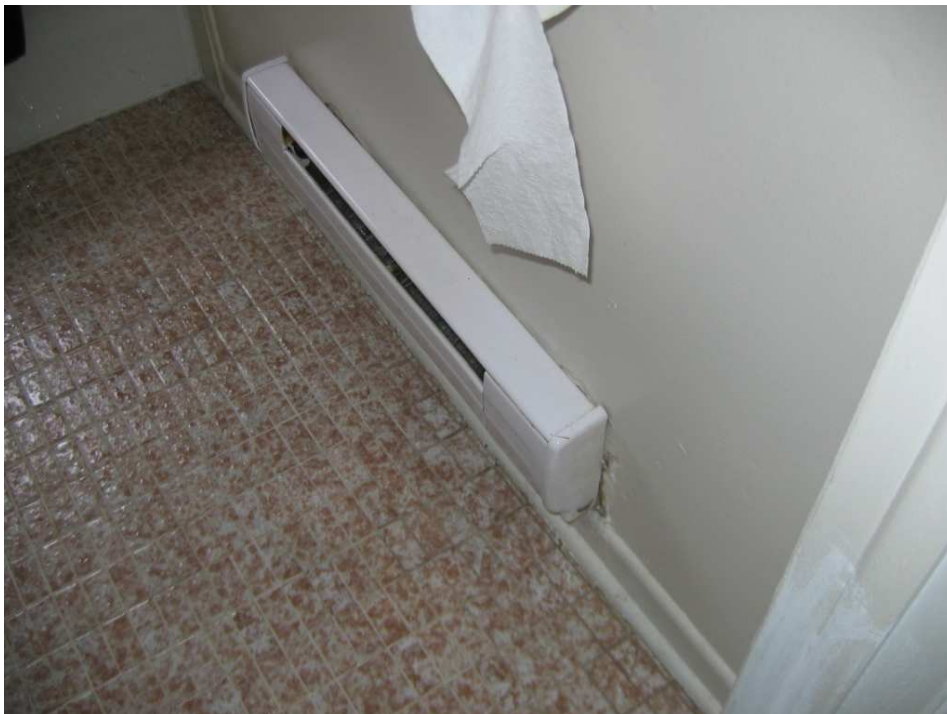
Photo 5 : Plinthe électrique dans un appartement
