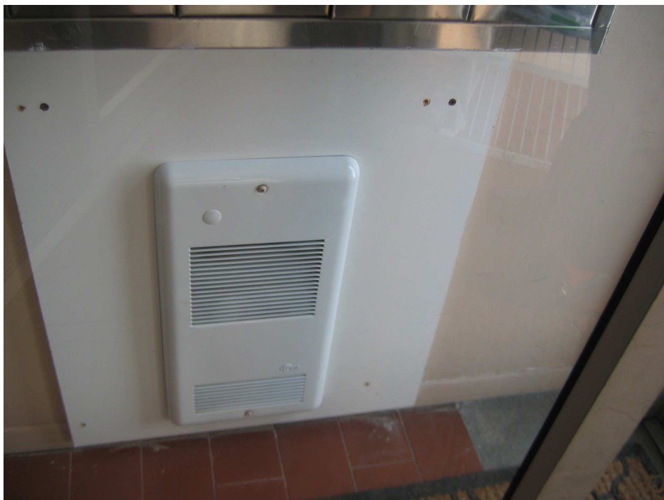
Photo 14 : Unité de chauffage électrique dans les passages communs
